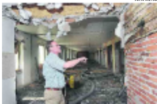
Juhani Ahokas esittelee Lappeenrannan sairaalan osastolla A8 kesäkuussa alkanutta perusteellista remonttia.
